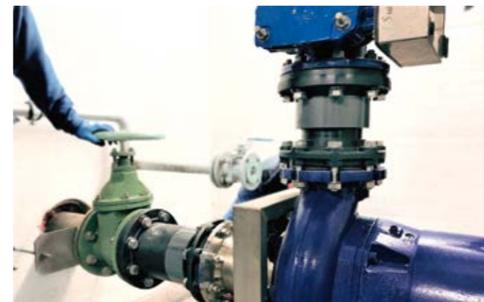
Abbildung 2: Quick-Twist-Installation an AW-Pumpe
